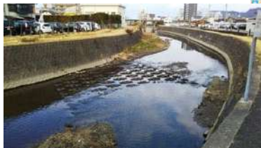
御坊川楠上橋
